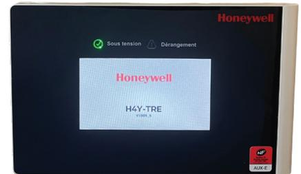
Le Tableau Répétiteur d'Exploitation H4Y-TRE permet le report à distance de la signalisation visuelle et sonore des différents états d'un Équipement de Contrôle et de Signalisation incendie H4YC et H4YA.
