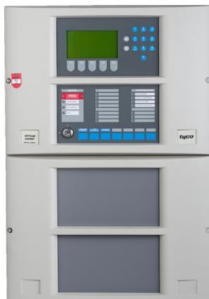
L'E.C.S. ZX4F peut gérer de 256 à 1024 points et peut être intégré dans un réseau de centrales. Il est équipé de 2 circuits de détection rebouclés, extensible à 8 circuits de détection rebouclés (jusqu'à 16 circuits avec centrale d'extension ZX4-BB). La centrale est intégrée dans un coffret robuste en métal.
